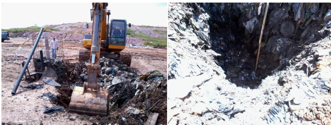
Figura 1: Escavação ao lado do dreno com a escavadeira “Poclain” e instalação das termoresistências fixadas à ripa de madeira.
