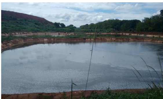
Figura c) Lagoa de Estabilização para o tratamento do Chorume
