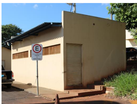
Figura 3 – Galpão externo de armazenamento dos RSS
