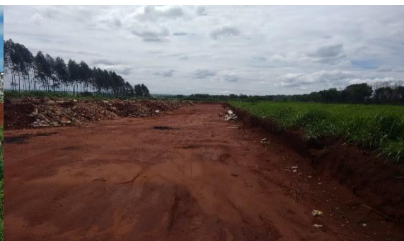
Figura b) Local de armazenagem dos Resíduos de Construção Civil
