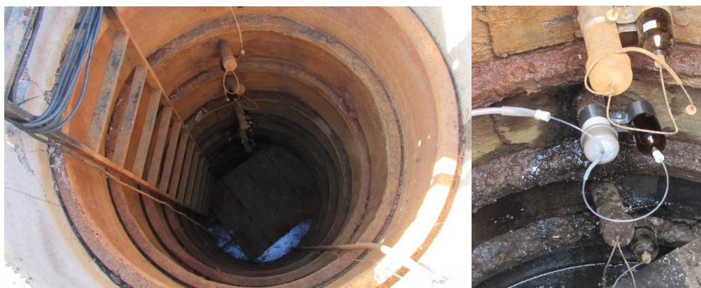
Figura 2. Estação de monitoramento de lixiviado (à esquerda) e detalhe de lisímetros instalados em diferentes profundidades (à direita).
