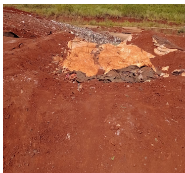
FIGURA 3 - Configuração das três células piloto no platô do aterro sanitário: vista superior das células construídas
